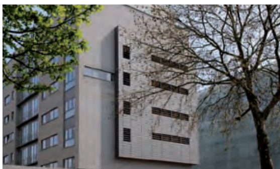
LAMBERMONT (BLOCS C ET D)
