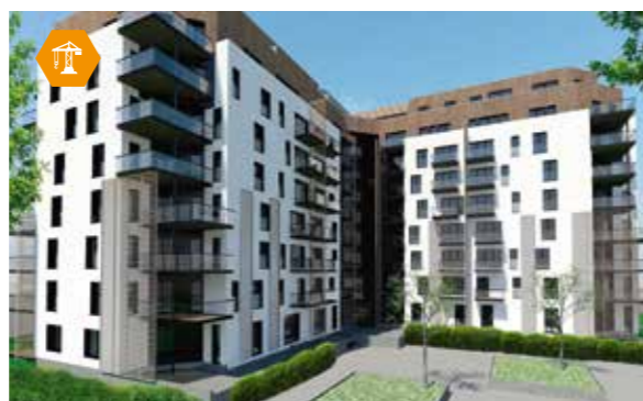
→ Ariane, après travaux
