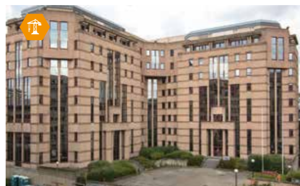
→ Ariane, avant travaux
